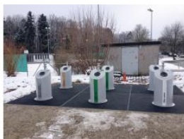
Unterflursammelstelle, Erlenstrasse/Dicklooweg, 8154 Oberglatt
