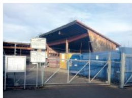
Zentrale Wertstoffsammelstelle, Bülachstrasse 17c, 8154 Oberglatt
