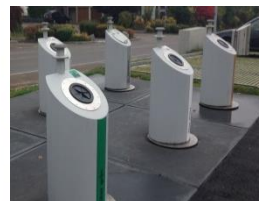
Unterflursammelstelle, Parkplatz Seniorenzentrum, Im Sack, 8154 Oberglatt
