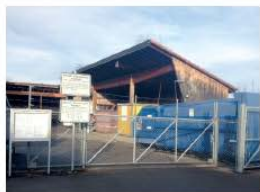
Zentrale Wertstoffsammelstelle, Bülachstrasse 17c, 8154 Oberglatt
