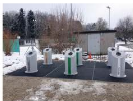
Unterflursammelstelle, Erlenstrasse/Dicklooweg, 8154 Oberglatt
