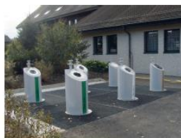
Unterflursammelstelle, Bülachstrasse, Furtacherhuus, 8154 Oberglatt
