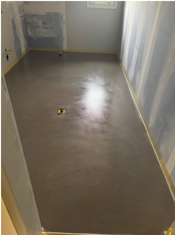
Gebäude Reckenwinkel 10 Der Bodenbelag wurde verlegt, die Steckdosen und Vorhangschienen montiert.
