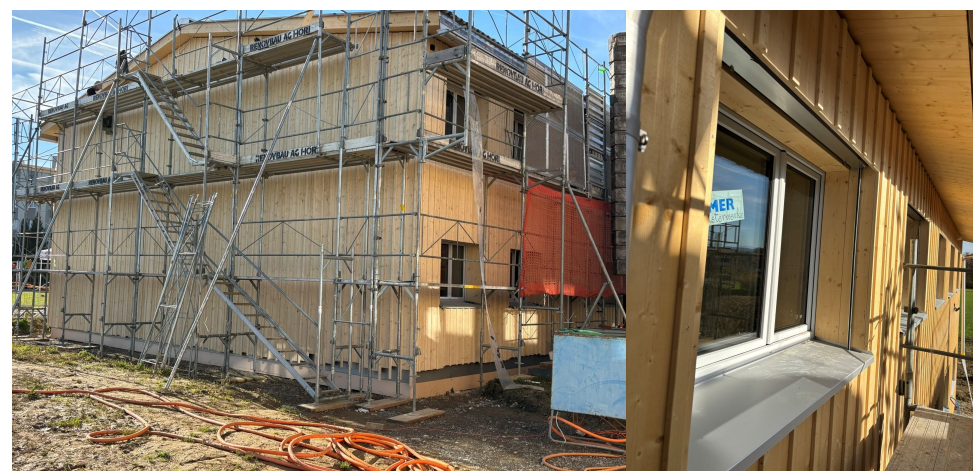
Gebäude Reckenwinkel 8 Stösse in den Wandplatten werden verspachtelt und für den Maler vorbereitet.
