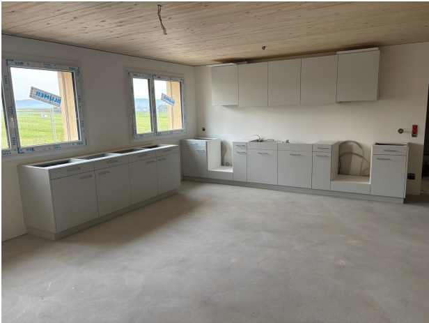
Gebäude Reckenwinkel 8+10 Die Aussentreppen wurden montiert.
