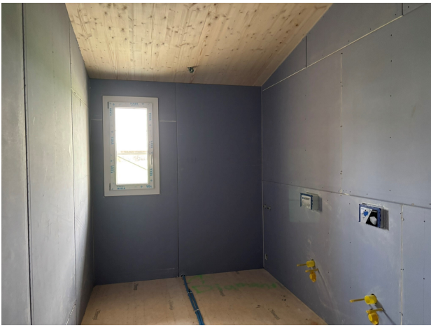
Auf beiden Gebäuden werden die Solarmodule und auch der Schneefang montiert.
