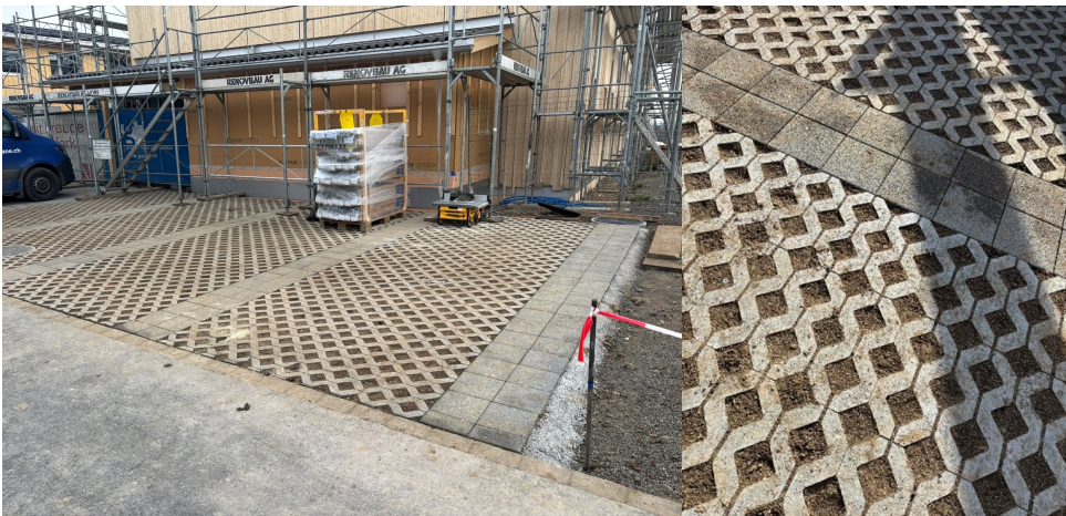
Die Rasengittersteine für die Parkplätze wurden verlegt.
