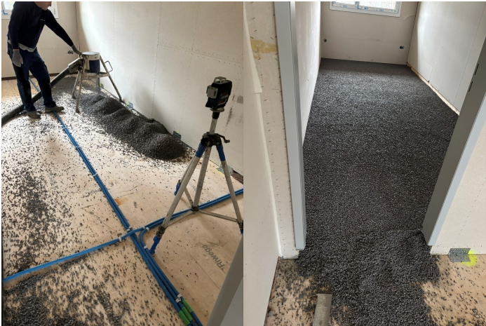
Gebäude Reckenwinkel 10 Im Obergeschoss wird die Schüttung eingebaut.
