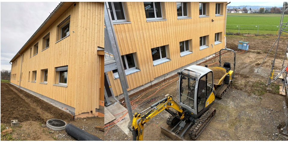
Gebäude Reckenwinkel 10 Die Fugenlosen Bodenbeläge in den Nasszellen wurden eingebaut.
