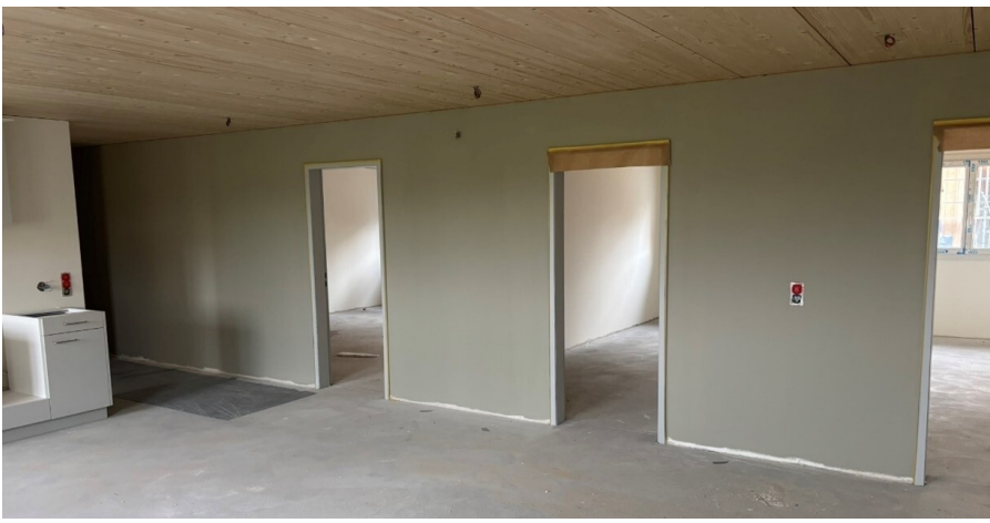
Die Montage der Küchen hat begonnen.
