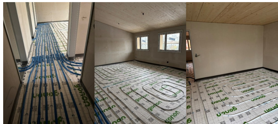
Gebäude R8 Die Arbeiten an der Fassade werden abgeschlossen.
