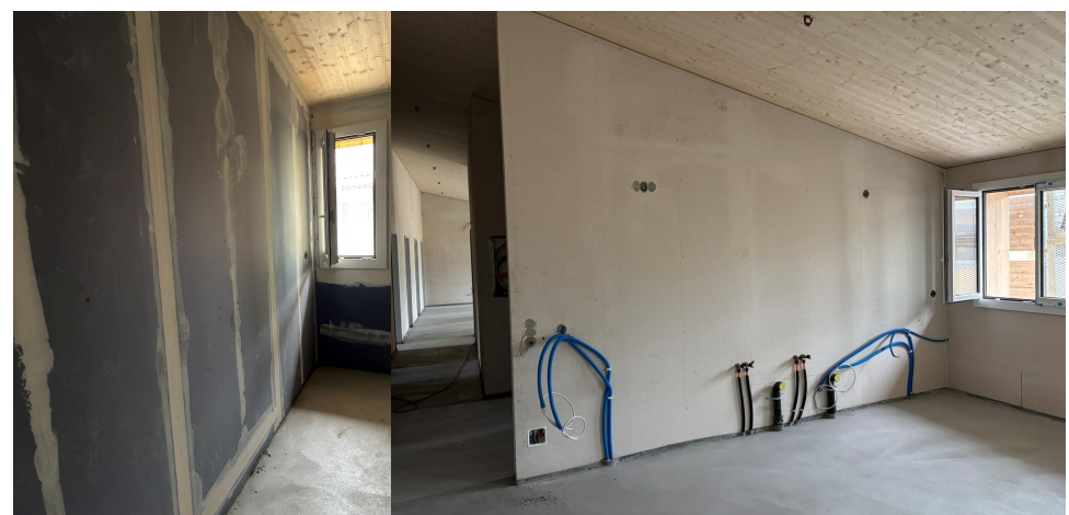
Gebäude Reckenwinkel 10 Kiesstreifen und Versickerungsmulden um das Gebäude wurden erstellt.
