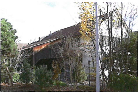
0098 Süd- und Westfassade
