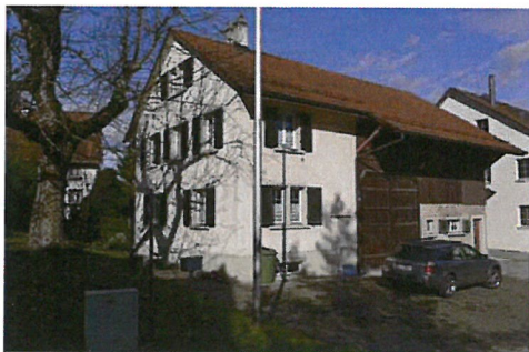
0097 Süd- und Ostfassade
