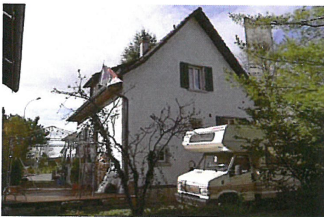
0110 Nordost- und Südostfassade
