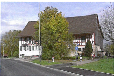
0181 Südwest- und Südostfassade
