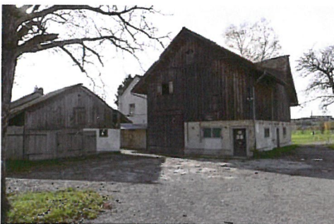
0132 Nordost- und Nordwestfassade
