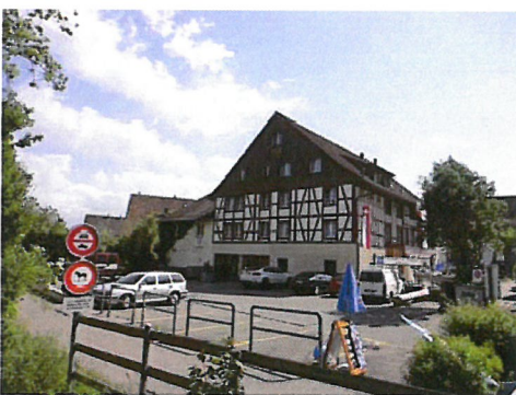
0450 Nordost- und Nordwestfassade
