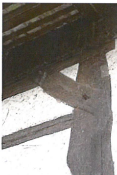
0144 Detail Kopfband an der Nordfassade
