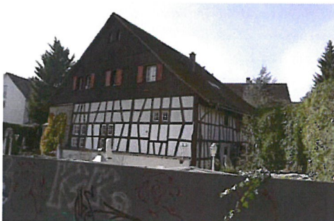
0134 Ost- und Nordfassade
