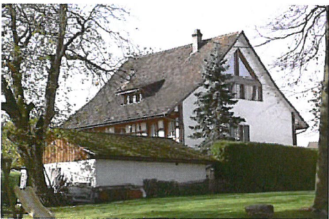
0138 Südost- und Nordostfassade
