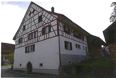
0171 Nord- und Westfassade
