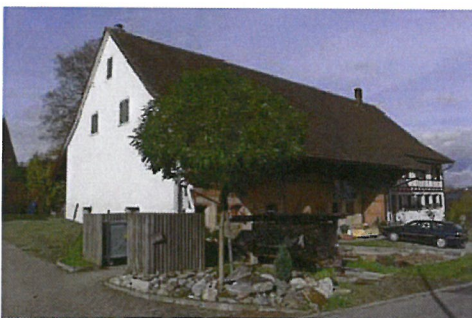
0164 Süd- und Ostfassade
