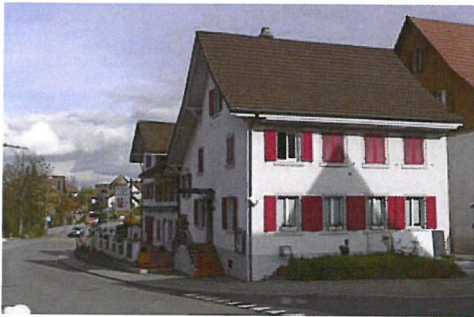
0187 West- und Nordfassade
