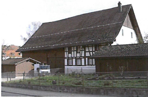
0190 West- und Südfassade
