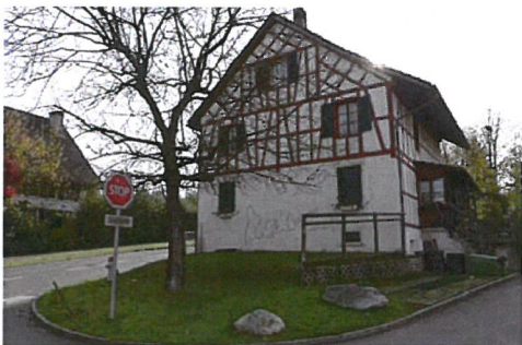
0225 Nord- und Westfassade
