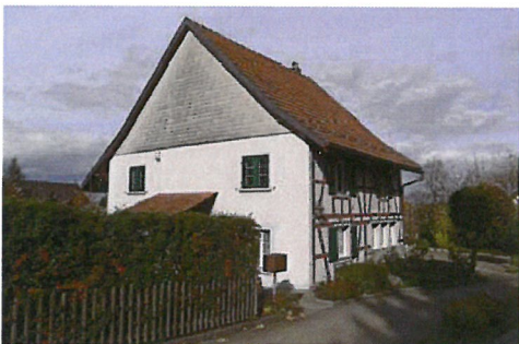
0235 Süd- und Ostfassade
