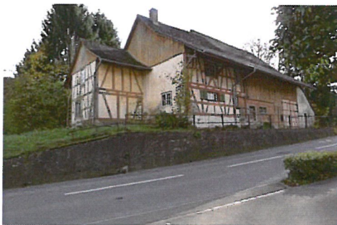
0234 Nordost- und Nordwestfassade
