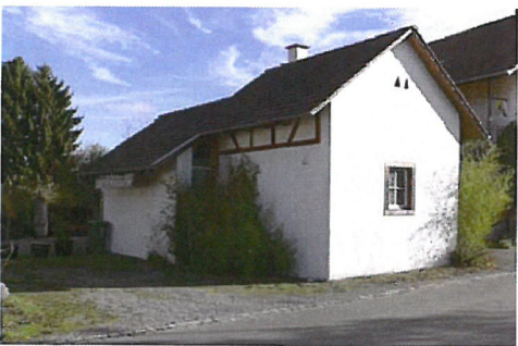
0048 Nordwest- und Südwestfassade
