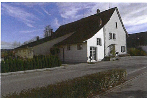
0045 Nordwest- und Südwestfassade
