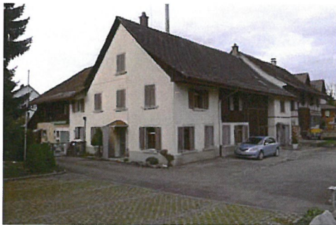
0314 Südwest- und Südostfassade
