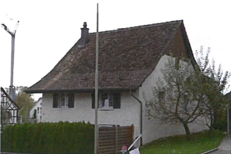
0305 Nordost- und Südostfassade
