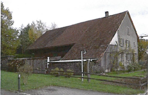
0283 Nordwest- und Südwestfassade
