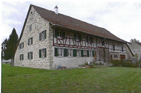
0281 Südwest- und Südostfassade
