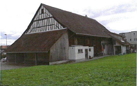
0282 Nordost- und Nordwestfassade
