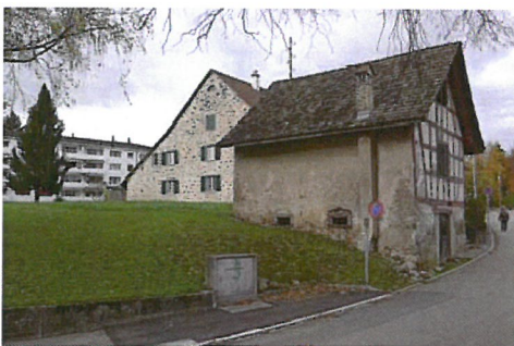
0276 Südwest- und Südostfassade
