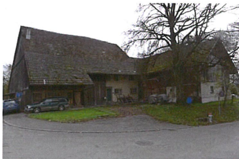
0266 Northwest- und Nordostfassade, Grafchaftsstrasse 6
