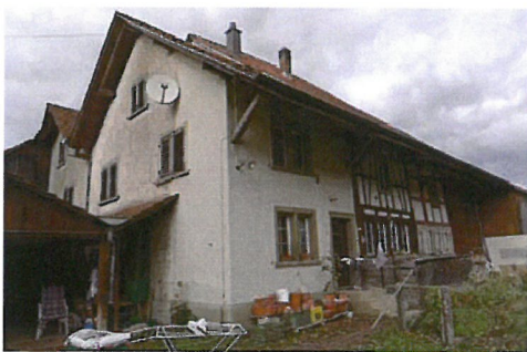
0265 Südwest- und Südostfassade, Im Hof 2
