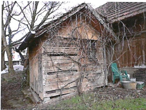
0445 Südwest- und Südostfassade
