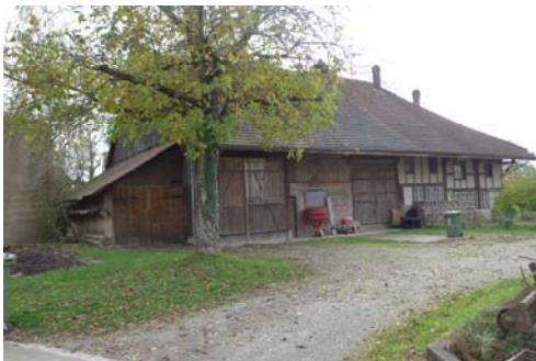
0269 West- und Nordfassade
