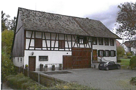
0239 Nordwest- und Südwestfassade
