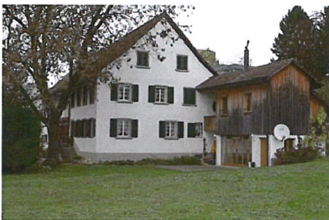
0240 Südwest- und Südostfassade
