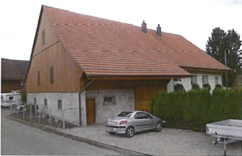
0247 Nordost- und Nordwestfassade
