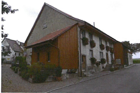
0241 Südwest- und Südostfassade
