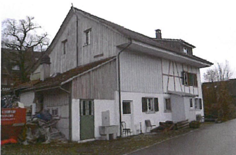
0336 Nordost- und Nordwestfassade
