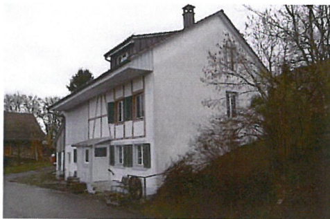
0335 Nordwest- und Südwestfassade
