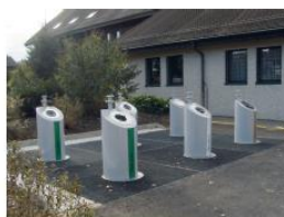
Unterflursammelstelle, Bülachstrasse, Furtacherhuus, 8154 Oberglatt
