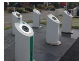
Unterflursammelstelle, Parkplatz Seniorenzentrum, Im Sack, 8154 Oberglatt
