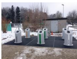
Unterflursammelstelle, Erlenstrasse/Dicklooweg, 8154 Oberglatt
